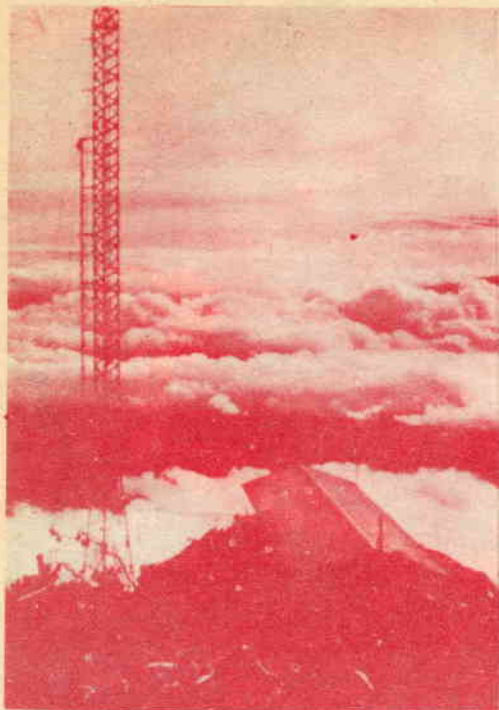
Fig. 3 - Ripresa fotografica della nuova stazione trasmittente VHF di Sabah, sul monte Kinabalu.
